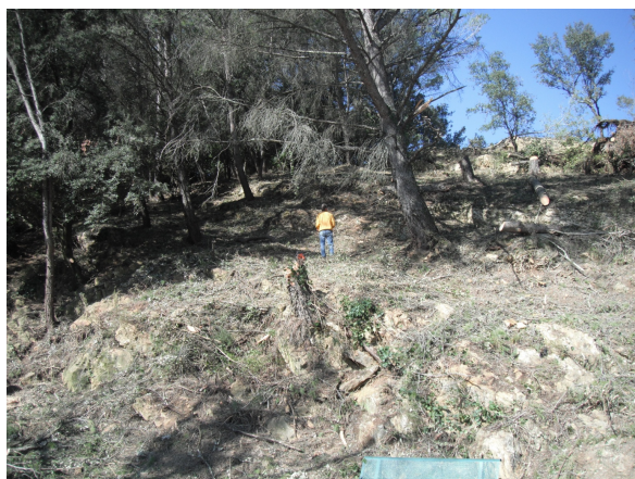
Protection incendie à Serviès
