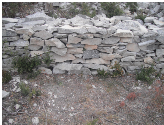
Muret en pierre sèche à Belvezet
