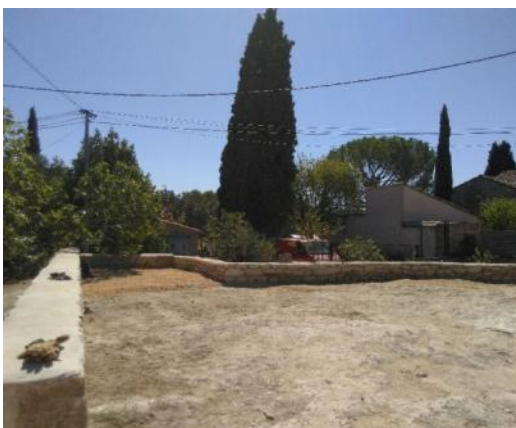
Mur en pierres bâties à Sagriès
