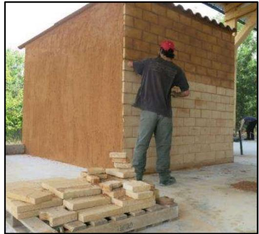
*Pose de briques en terre crue au local technique du Hangar à Vallabrix 2023*
